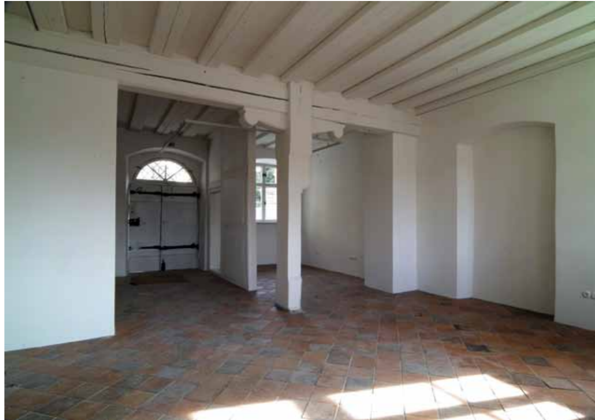
Abb. 10: Erdgeschoss: ehemalige Eingangssituation mit nachempfundenem Ziegelboden und den mächtigen Unterzug unterstützende Holzstütze. (Foto: Conn & Giersch)
