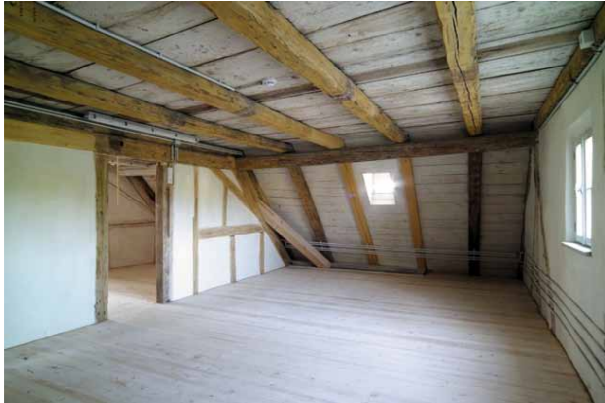
Abb. 11: Dachgeschoss: Blick auf die für dieses Geschoss typische Gestaltung mit Ockergelbfassung der konstruktiven Hölzer und geweißten Oberflächen nicht tragender Elemente und Füllungen. (Foto: Conn & Giersch)
