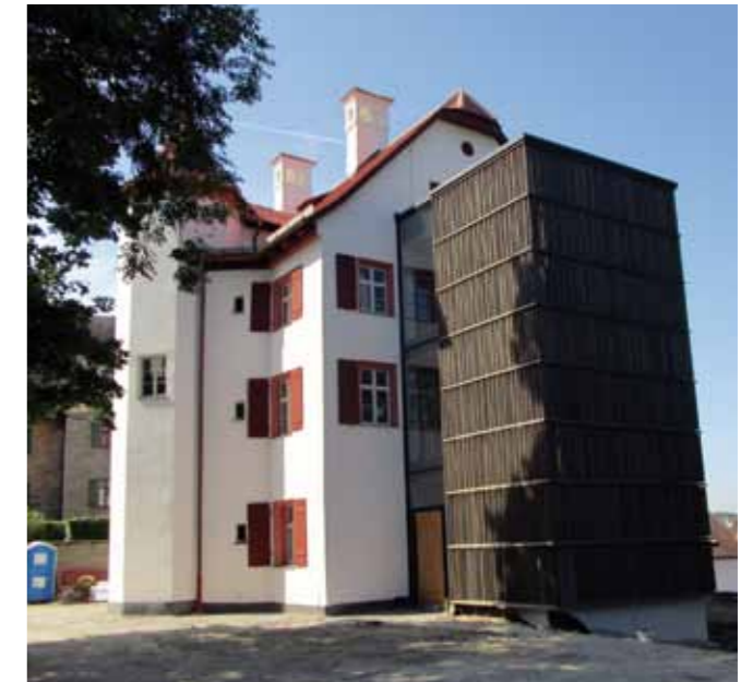
Abb. 9: Fotografie der sanierten Fassade mit Anbau während der Bauzeit. (Foto: Conn & Giersch)
