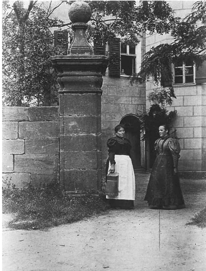
Abb. 8: Ende 19.Jh.: Fotografie mit Blick auf Ostseite mit Eingang: Gestaltung der Flächen in hellem Farbton mit dunklem, breiten Fugenstrich und noch heller abgesetzten Fensterleibungen. (Foto: Brunel-Geuder)
